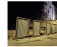
Demolition, Király Street Bontási terület, Király utca
