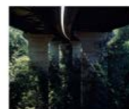
Viaduct, Switzerland Völgyhíd, Svájc
