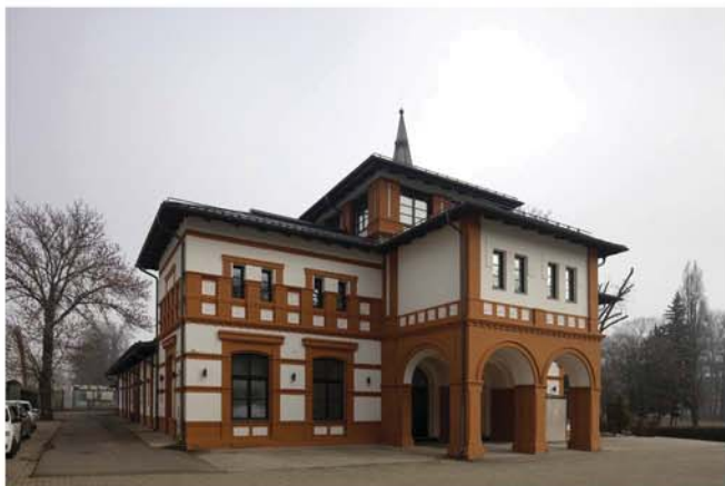
Miskolc, Népkerti Vigadó - teljes felújítás 2017.
