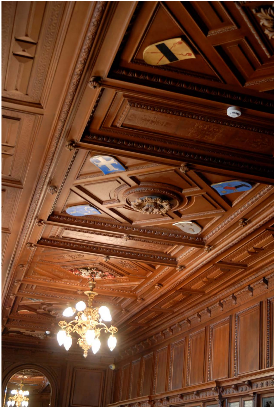
Tolcsva, volt Szirmay-Waldbott kastély felújítása: műemlék könyvtár faszobrász restaurátori munkái
