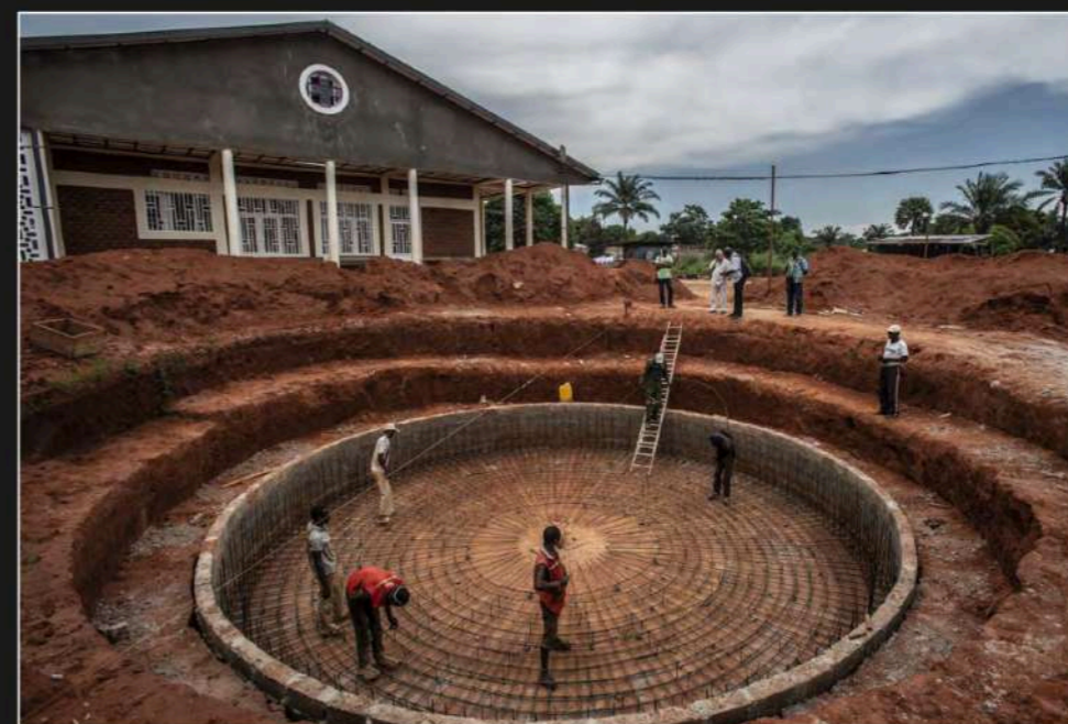
Épül az óriási ciszterna a mbuji-mayi szemészeti centrum mellé. 2019-re minden forrás összeállt ahhoz, hogy európai értelemben is modern szemészeti kórház épüljön fel a negyedszázados kitartó misszió „megkoronázásaként”.
