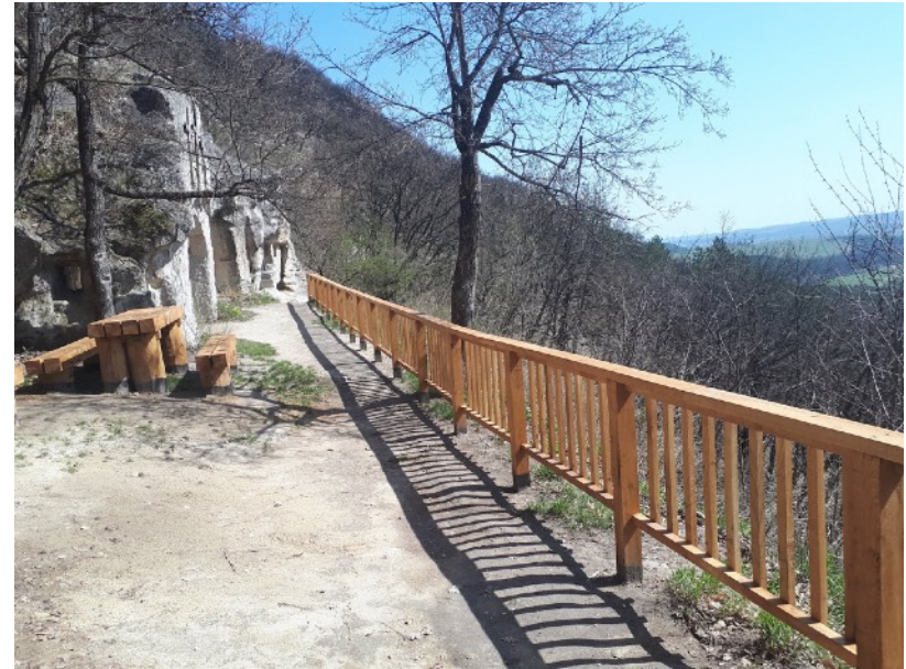
híd és egyéb építmények, Mátraverebély-Szentkút, 2017-2018
