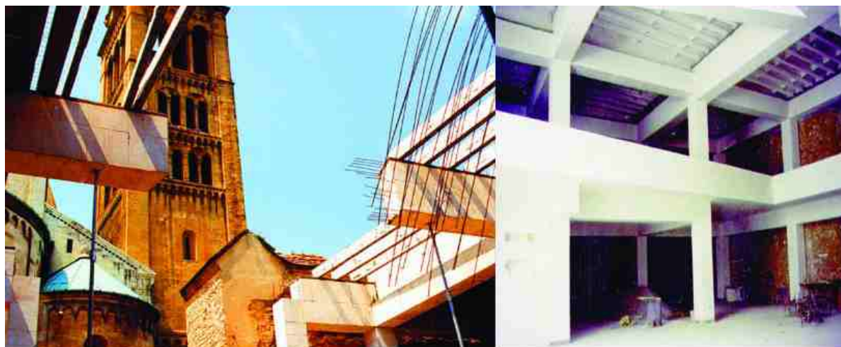
PÉCS DÓMKŐTÁR ÉPÍTÉS KÖZBEN ÉS SZERKEZETKÉSZ ÁLLAPOTBAN
