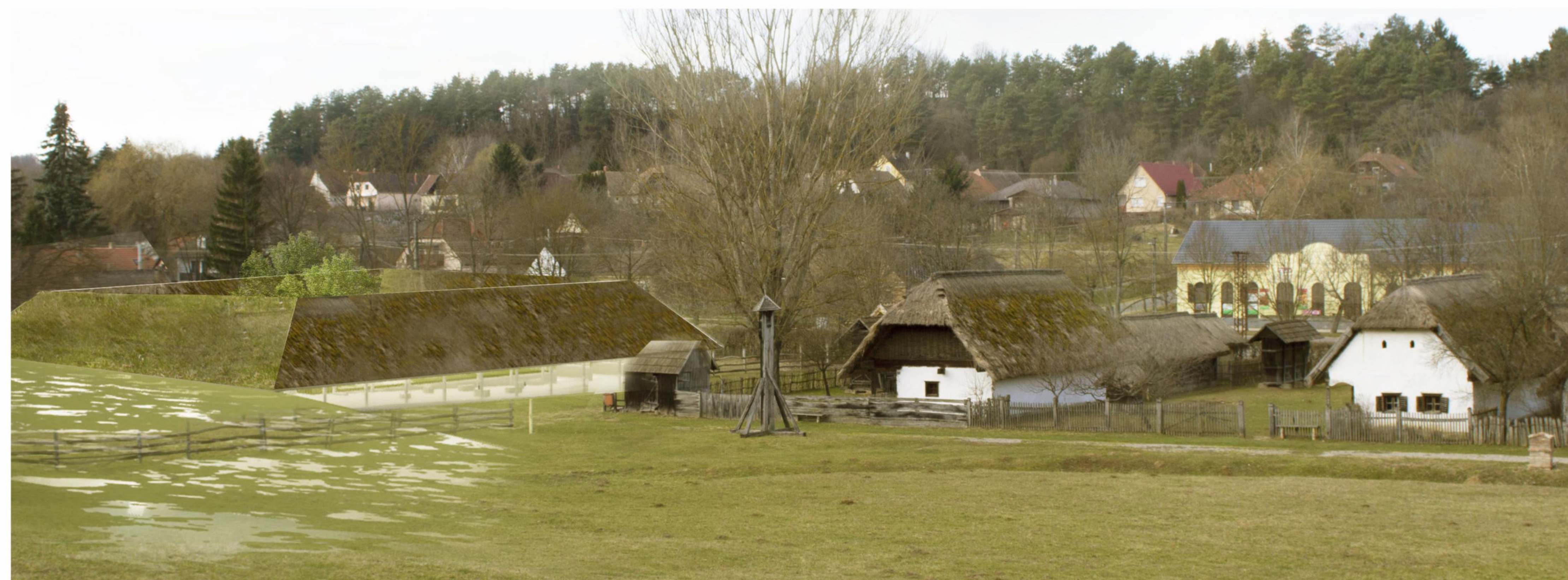
a látogatóközpontot egy mesterséges domb veszi körül, amely a bejárati homlokzat kivételével elrejtja az épület tömegét
