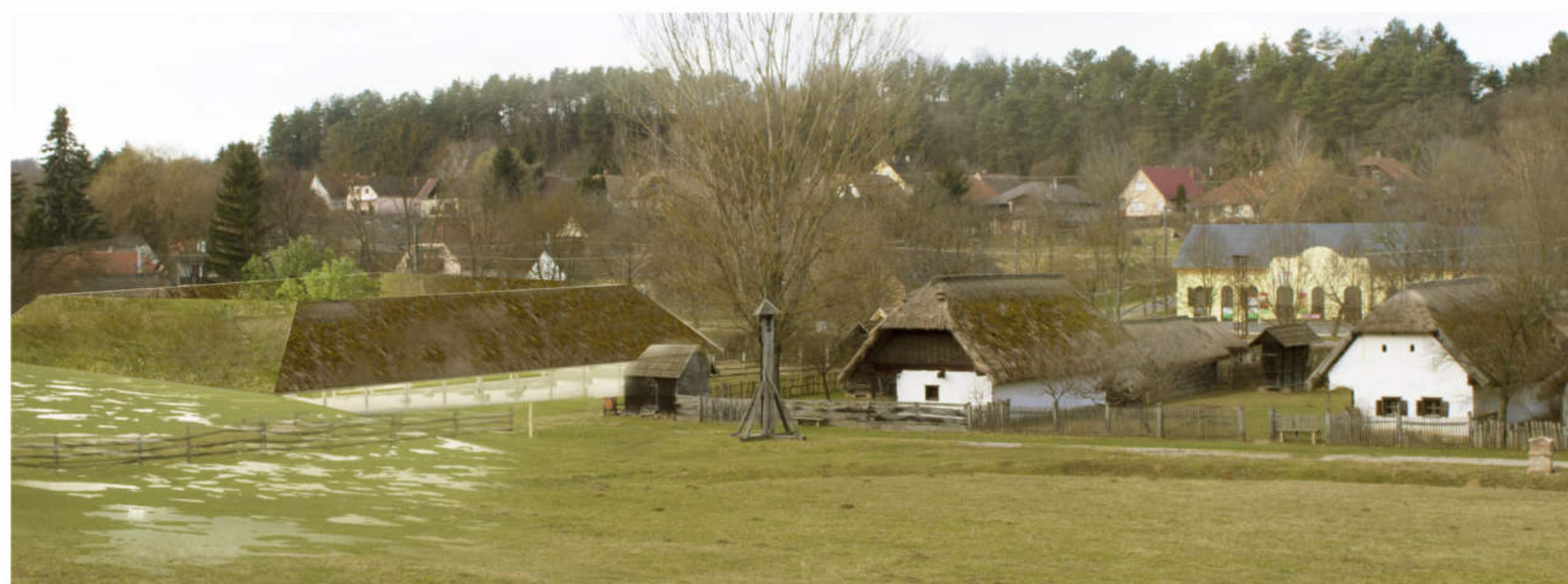
a látogatóközpontot egy mesterséges domb veszi körül, amely a bejárati homlokzat kivételével elrejtje az épület tömegét
