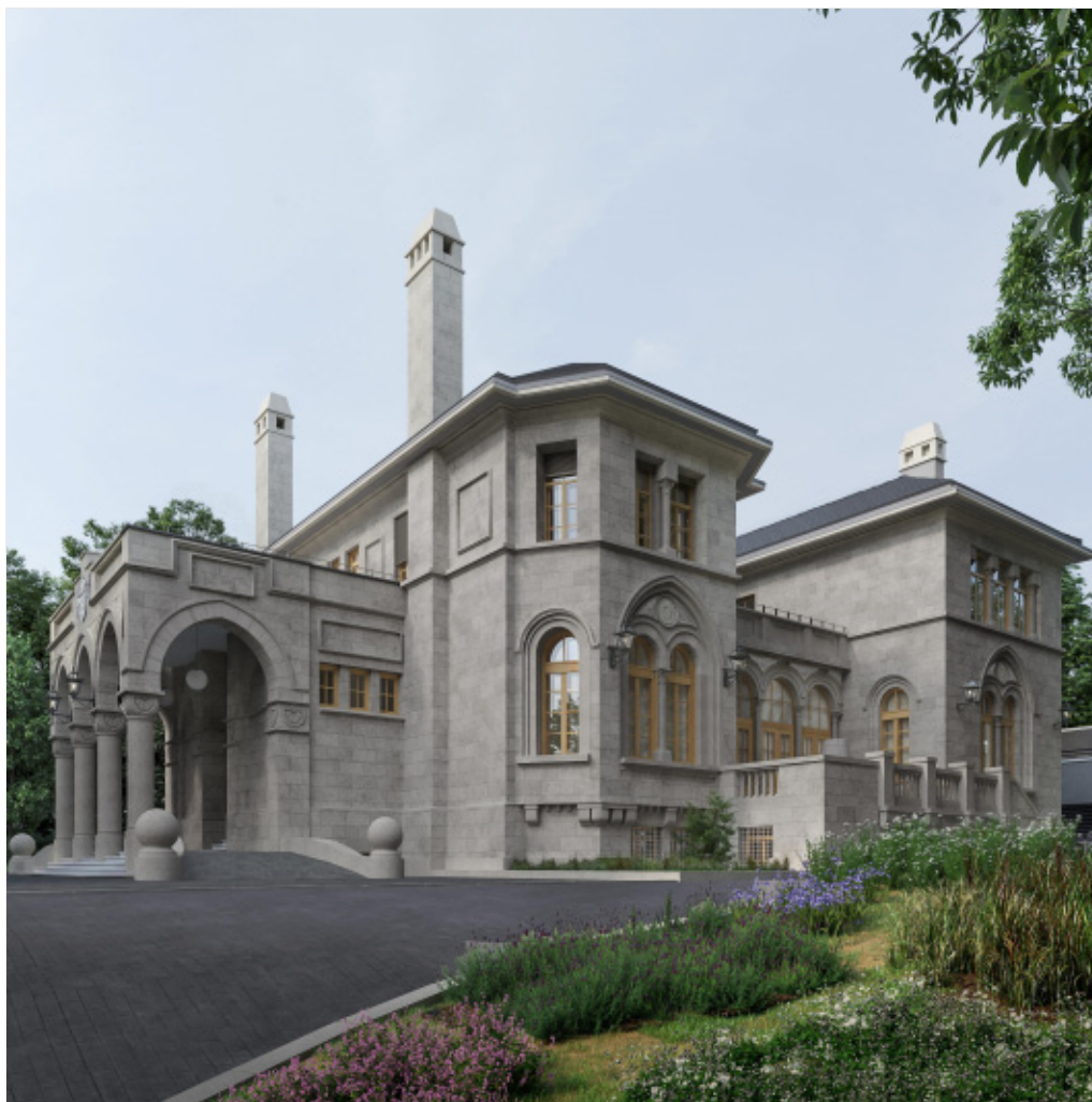
Megvalósulás alatt: Ankara, Magyar nagyköveti rezidencia felújítása
