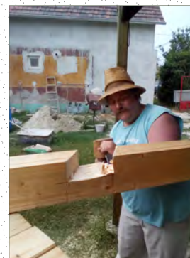
Érdliget · Molnár-Kovács ház · terv: 2015-16 · Födémépítés: 2017
