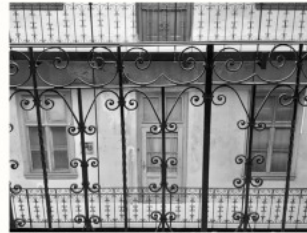
Lakás műteremmé alakítása, Fridrich Lászlóval, Under Construction Műterem MEGVALÓSULÁS ALATT 2023.
