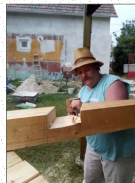
Érdliget · Molnár-Kovács ház · terv: 2015-16 · Födémépítés: 2017
