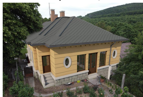
Eplény, vasútállomás felújítása
