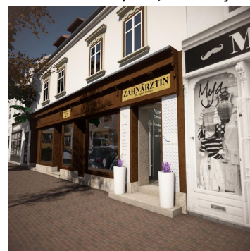
Sopron, várkerületi ház felújítása
