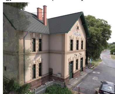
Bakonyszentlászló, vasútállomás felújítása
