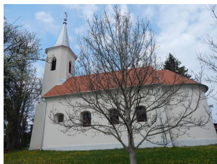
Nagyrákos rk templom felújítása
